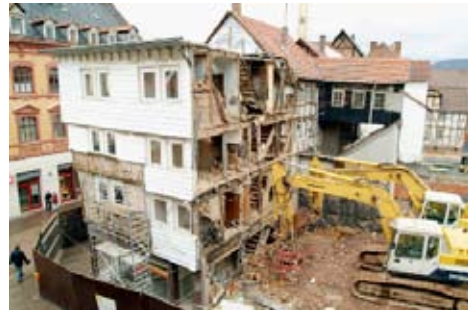
Abriss der Gebäude Herrengasse 1 und 3
